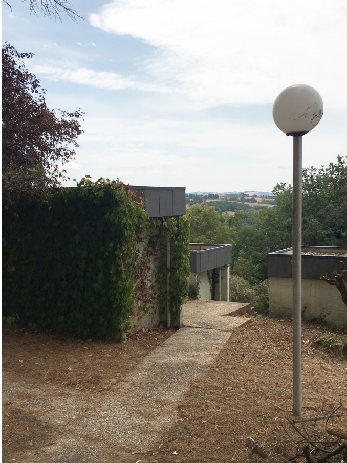
Vue de l'accès depuis le plateau haut
