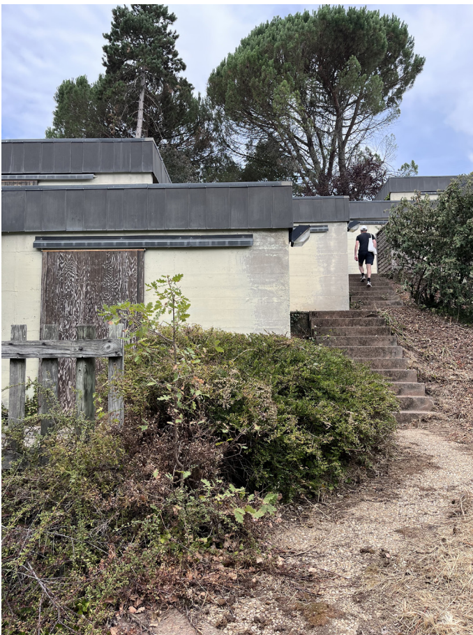
Vue des accès commun
